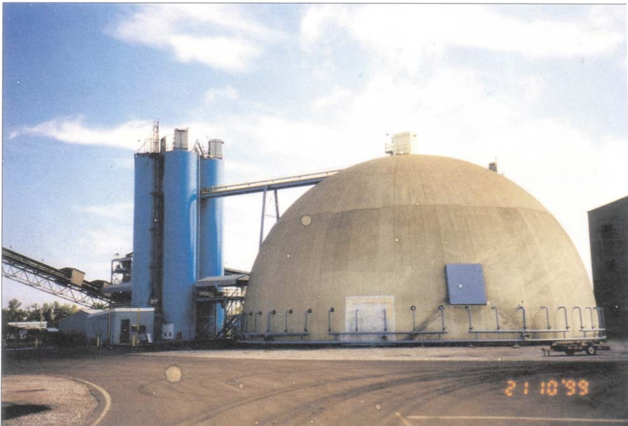
מגורת DOME קיבולת 15000 טון אפר מרחף. מגורות להעמסות למכיליות (Load-out facilities) Wateree Powerstation USA צילום : אהרון בועז
