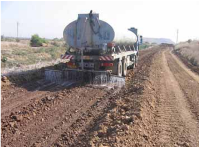
ציור מס' 2.2: "פתיחה" וחרישה ראשונית של הקרקע החרסיתית (ימין) והרטבת הקרקע לפני המשך עבודת התיחוח (שמאל)
