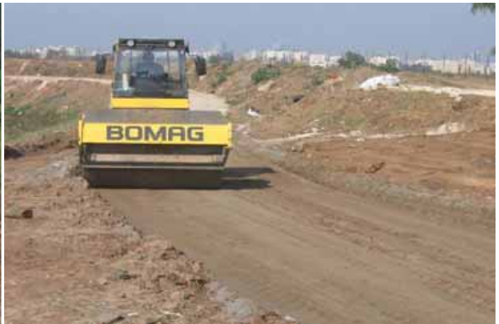
ציור מס' 2.7: הידוק הקטע המיוצב באמצעות מכבש ויברציוני חלק (ימין) והסדרת צד דרך להבטחת ניקוז והכנת שטח לזריעה (שמאל)
