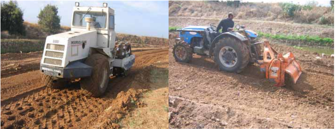
ציור מס' 2.3: תיחוח הקרקע באמצעות מתחחת חקלאית קלה (ימין). הידוק הקרקע החרסיתית באמצעות מכבש רגלי כבש (שמאל)
