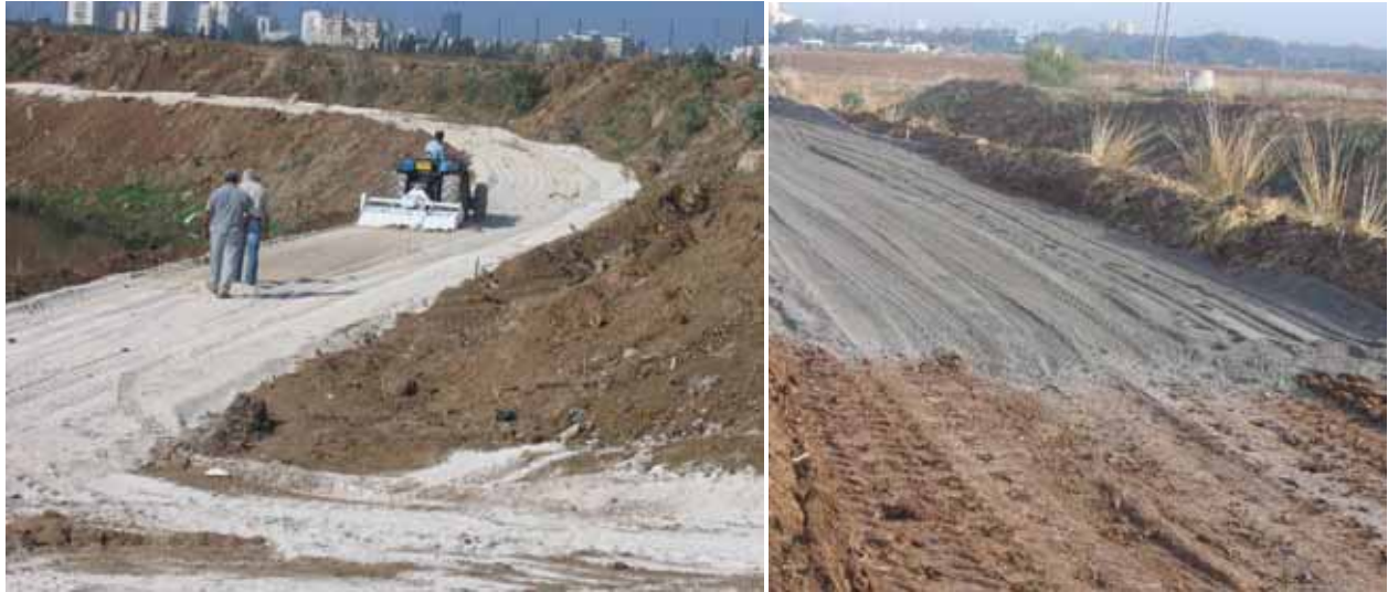
ציור מס' 2.4: אפר פחם תחתי לאחר פיזור באחד מקטעי המשנה (ימין). תהליך תיחוח תערובת הבסיס בקטע משנה הכולל חרסית וחומר מודרג (שמאל)
