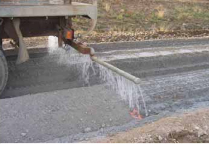
ציור מס' 2.6: פעולות תיחוח והרטבה של תערובת החומרים בתוספת המייצב, לקבלת תערובת אחידה לפני עיבוד סופי של פני שטח והידוק.
