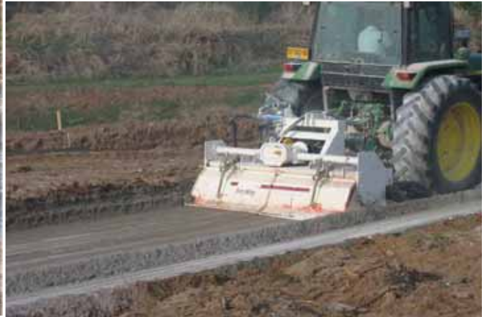
ציור מס' 2.6: פעולות תיחוח והרטבה של תערובת החומרים בתוספת המייצב, לקבלת תערובת אחידה לפני עיבוד סופי של פני שטח והידוק.
