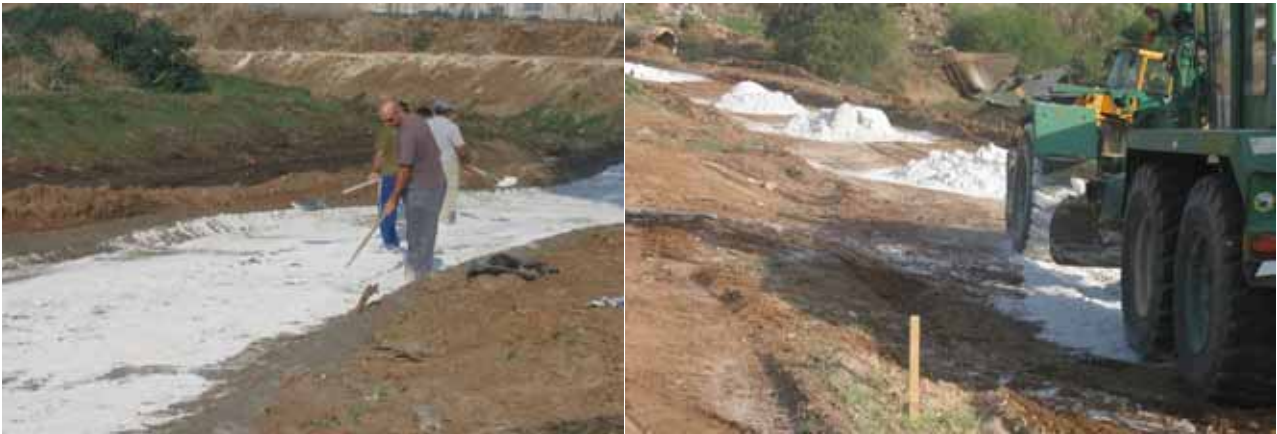
ציור מס' 2.5: תהליך פיזור ראשוני של חומר מייצב באמצעות מפלסת (ימין) והשלמת פריסה אחידה של המייצב בעבודה ידנית (שמאל)
