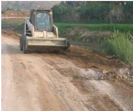
ציור מס' 2.7: הידוק הקטע המיוצב באמצעות מכבש ויברציוני חלק (ימין) והסדרת צד דרך להבטחת ניקוז והכנת שטח לזריעה (שמאל)
